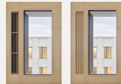
Offene und geschlossene Lüftungsklappe mit dem Durchgreifschutz.
